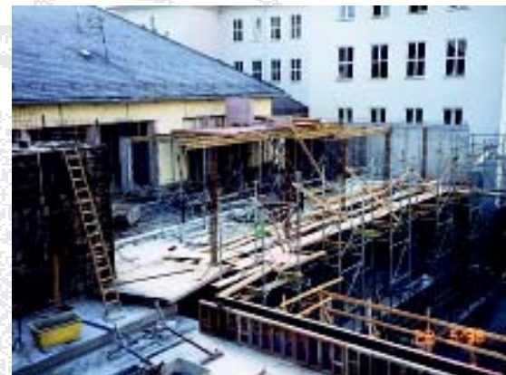
Mensa I - Stadtmitte, im Bau
