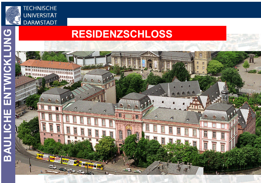
Bild 11 Sanierung des Schlosses
