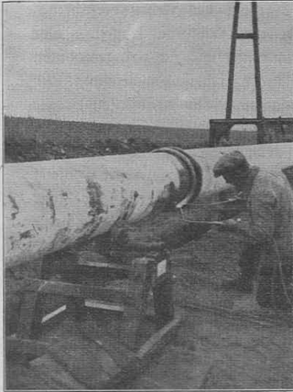
Abb. 1 Schweißen einer Verbindung mit Bördelmuffe eines Gasfernversorgungsrohres.
