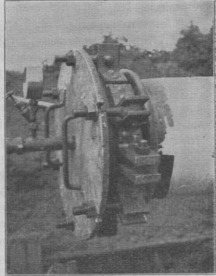
Abb. 2 Rohrende mit angeschraubtem Abpreßdeckel für Druckprüfung.
